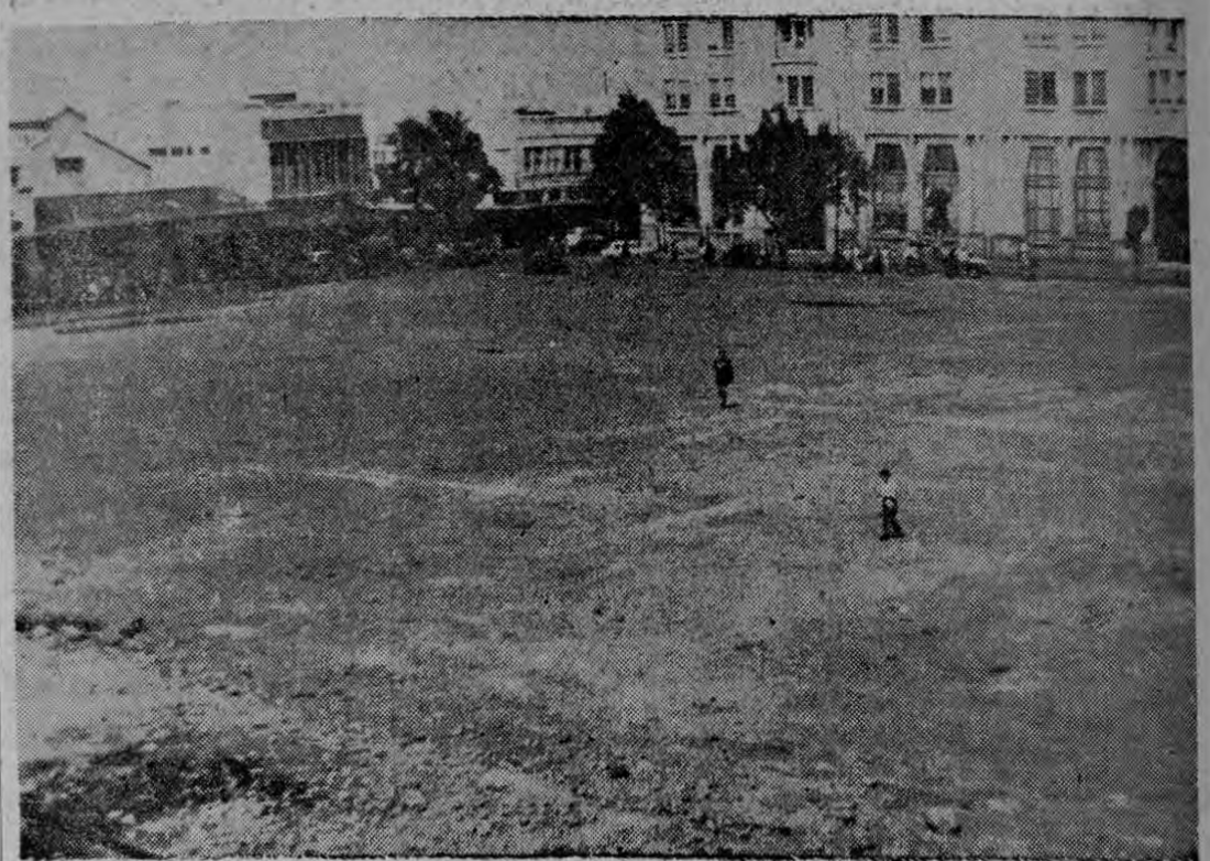
2.800 metros cuadrados para construcciones; el resto, para zonas verdes. El edificio para el Banco Central, y los jardines a cargo de la Municipalidad capitalina
